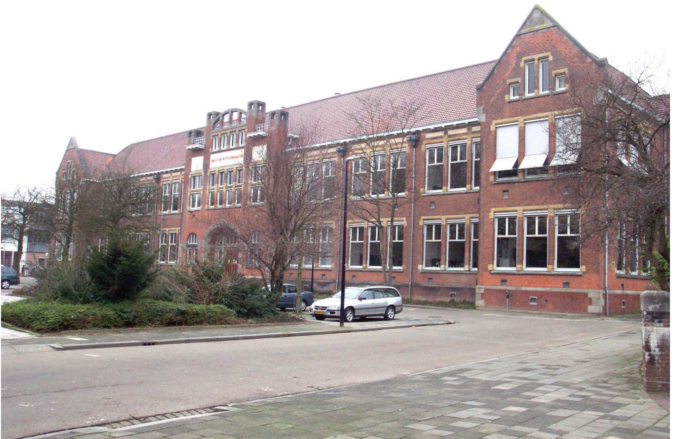
voorgevel Johan De Wittgymnasium aan het Oranjepark te Dordrecht
