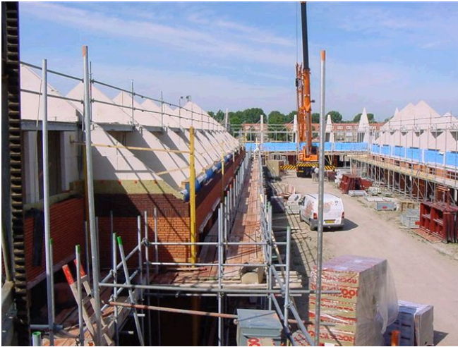
overzicht bouw woningen
